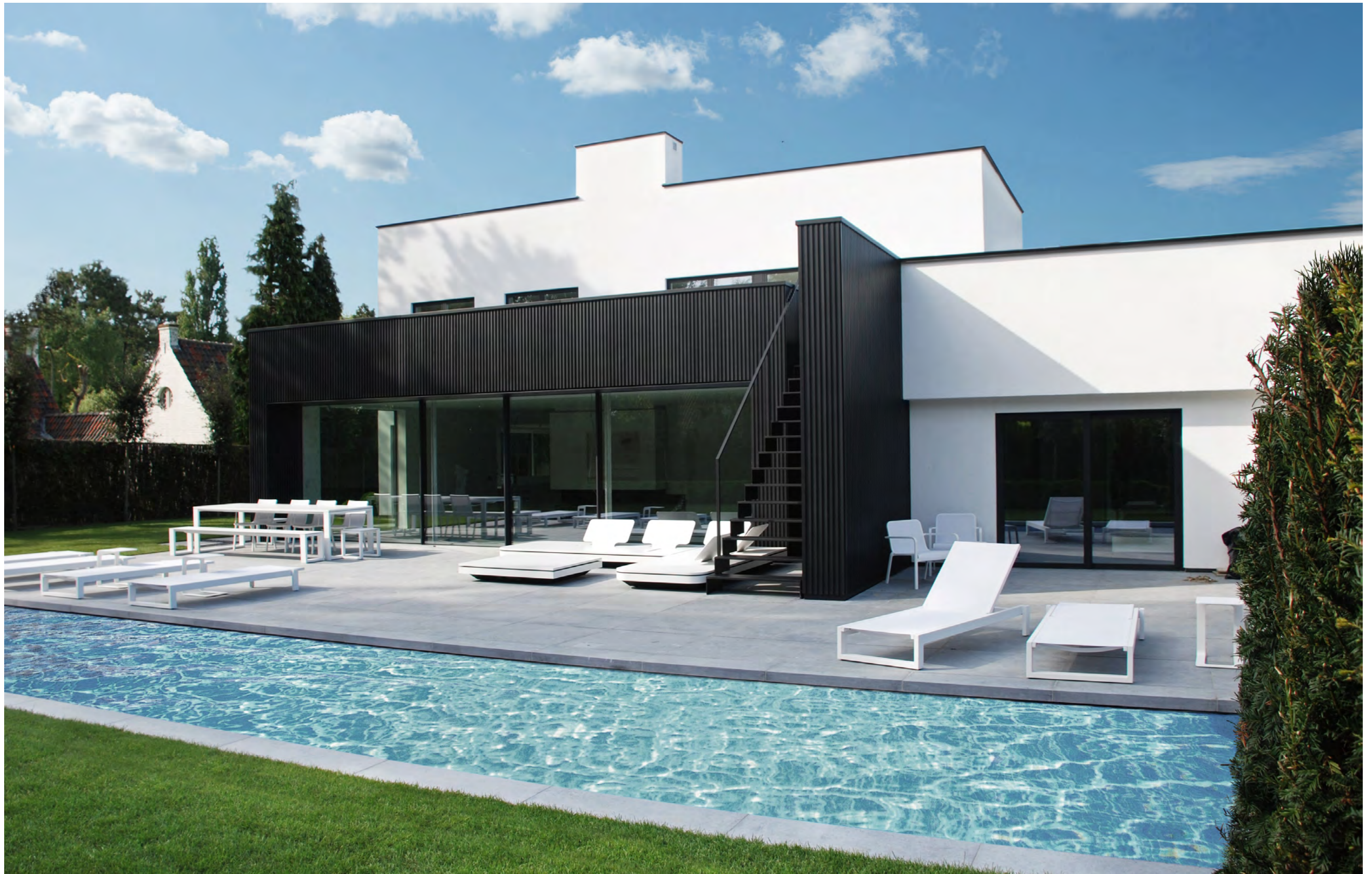
© Dubois Houtskeldebouw | Alinel Typ A | Knokke-Heist | Architect: Hans De Keyser | Arttec Groep
