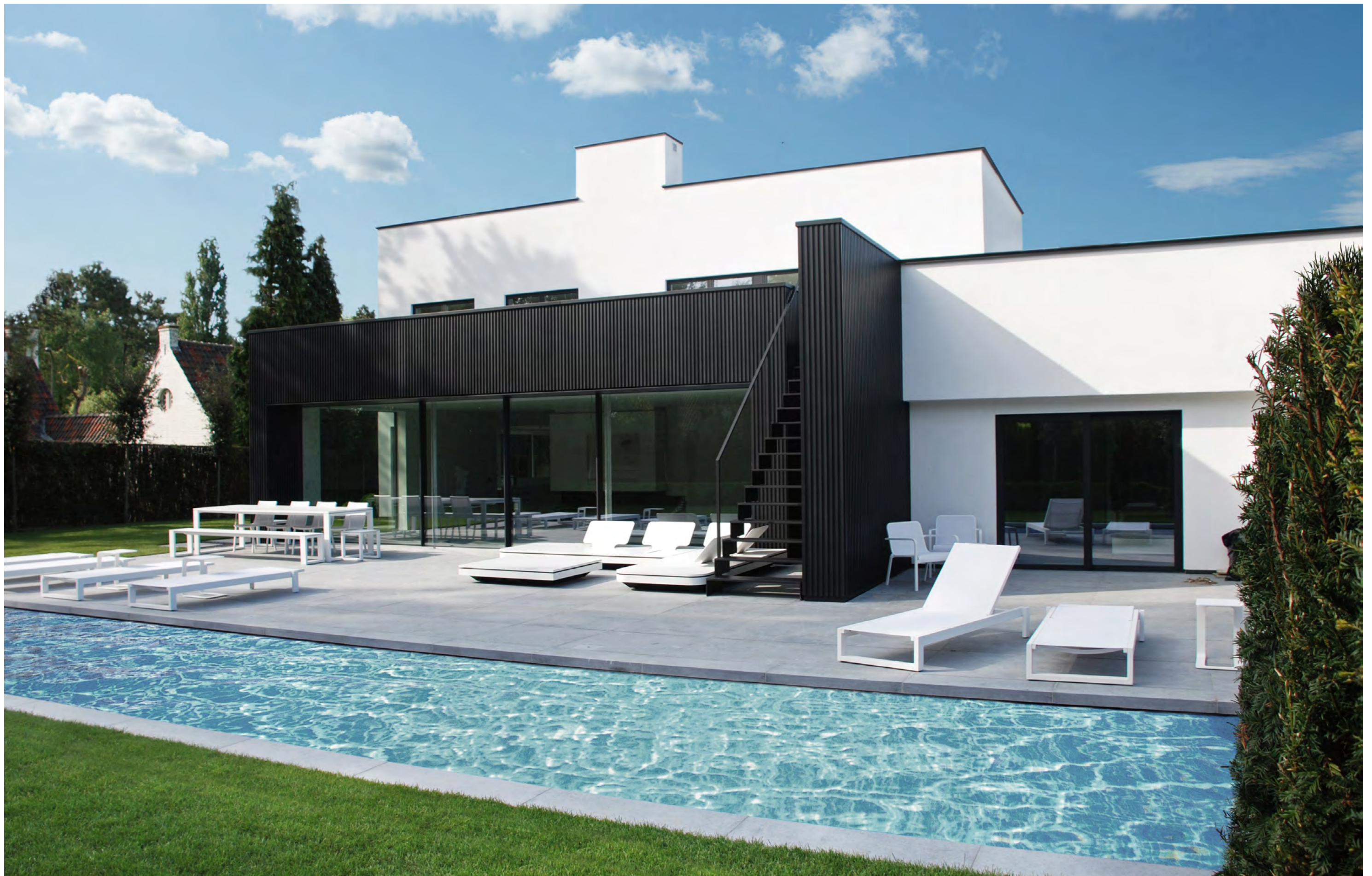
© Dubois Houtskeletbouw | Alinel Type A | Knokke-Heist | Architect: Hons De Keyser | Arttec Groep
